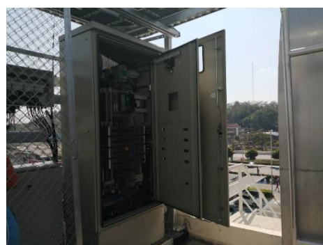
Solar AC Distribution Board (มุมมองให้เห็นสถานที่ติดตั้ง ถ่ายปิดและเปิดตู้)
