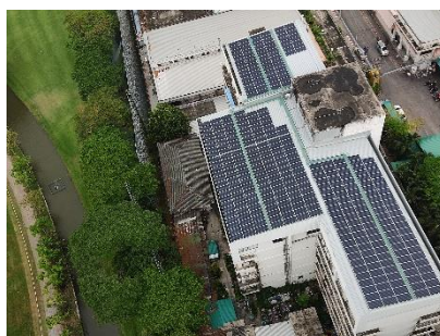
ภาพมุมสูงด้วยโดรนหรืออาคารที่ติดตั้ง
