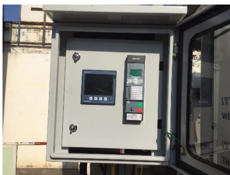
เครื่องวัดคุณภาพไฟฟ้าและรีเลย์ที่ใช้ป้องกัน
