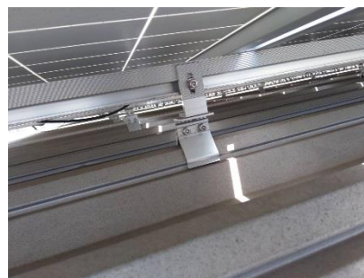
โครงสร้างยึดจับของแผง(ใต้แผง)
