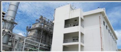
อาคารที่เกี่ยวข้องกับการผลิตพลังงานไฟฟ้า
