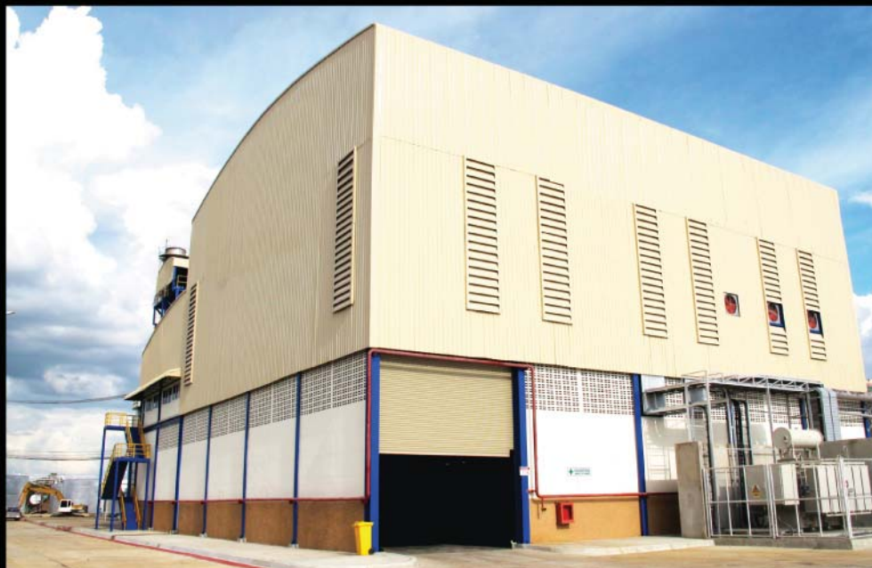
2. อาคารเครื่องต้นกำลังและเครื่องกำเนิดไฟฟ้า (Power House)
