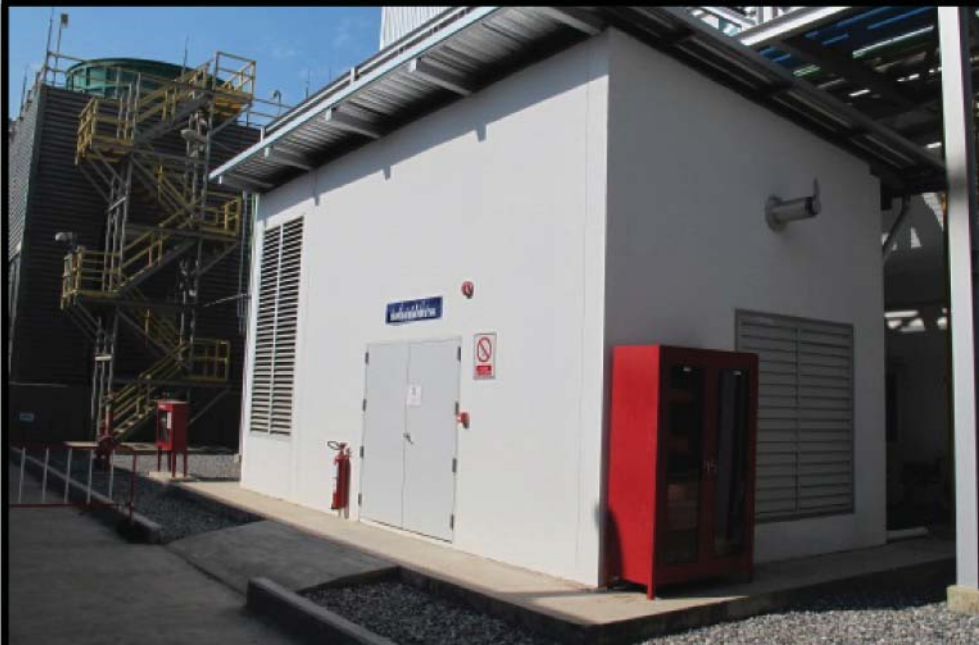
10. อาคารเก็บสารเคมี
