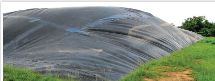
3. บ่อดินสำหรับหมักก๊าซชีวภาพ
