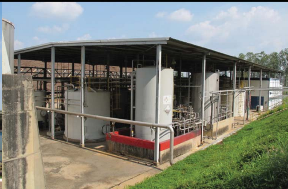
7. อาคาร Demineral Water Plant
