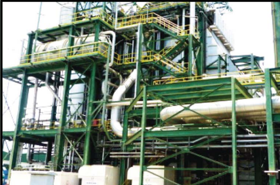
6. อาคารหม้อน้ำ (Boiler)
