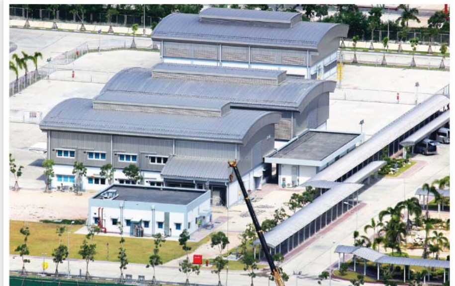
4. อาคารเก็บวัสดุอุปกรณ์
