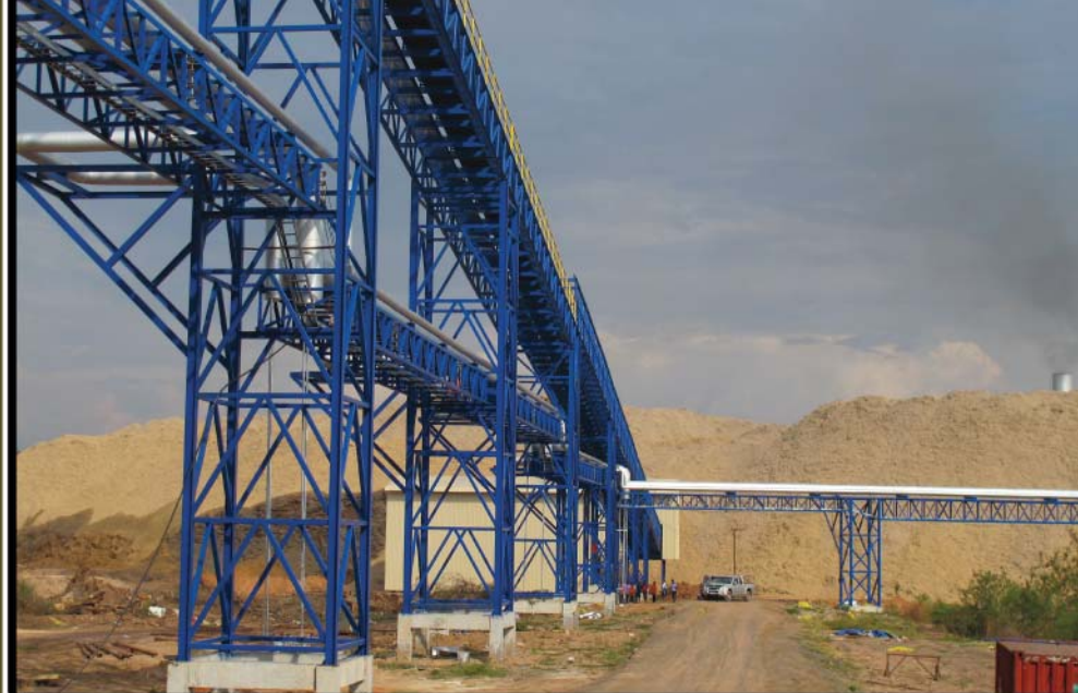
11. โครงสร้างขนส่งลำเลียงเชื้อเพลิง ที่มีความสูงตั้งแต่ 10 เมตรขึ้นไป
