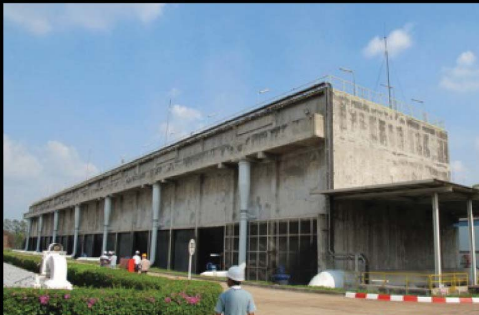
5. อาคารหอทำความเย็น (Cooling Tower)
