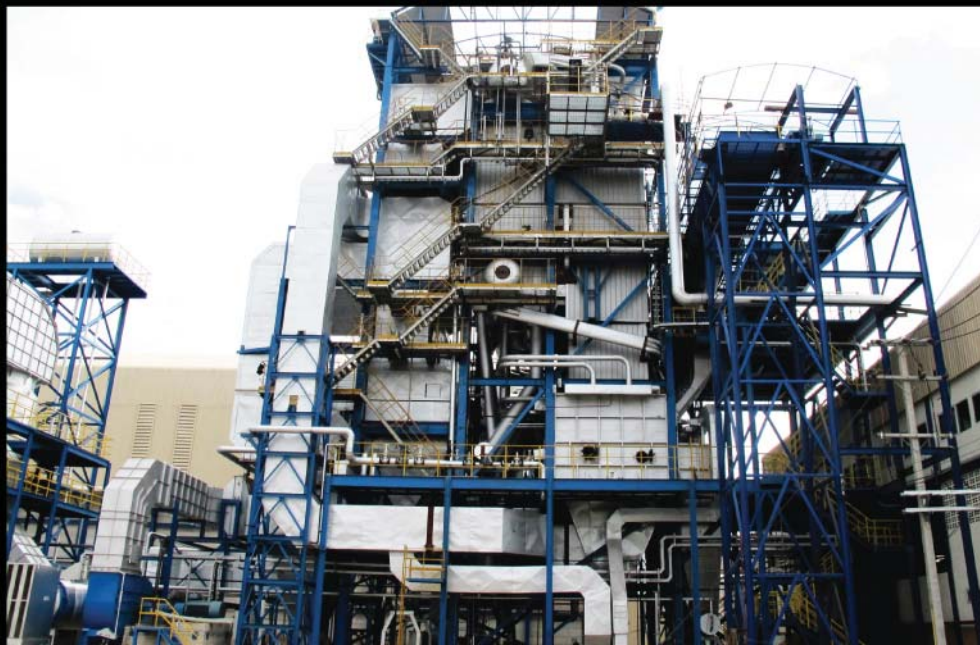
6. อาคารหม้อน้ำ (Boiler)
