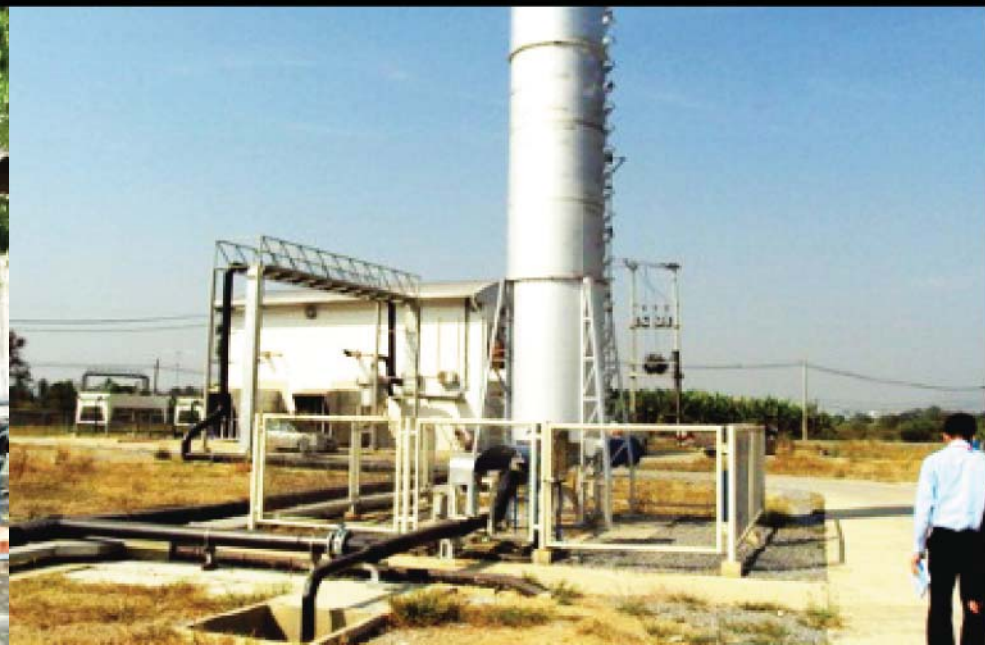
6. หอเผาบำบัดก๊าซชีวภาพ ที่มีความสูงตั้งแต่ 10 เมตรขึ้นไป
