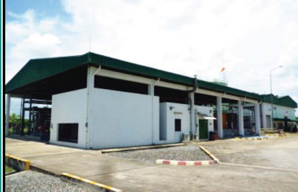
7. อาคาร Demineral Water Plant
