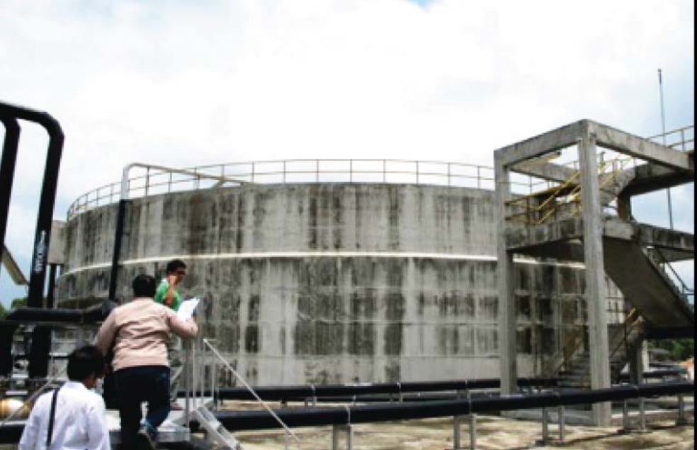
3. บ่อหมักก๊าซ ที่มีความจุตั้งแต่ 100 ลูกบาศก์เมตรขึ้นไป
